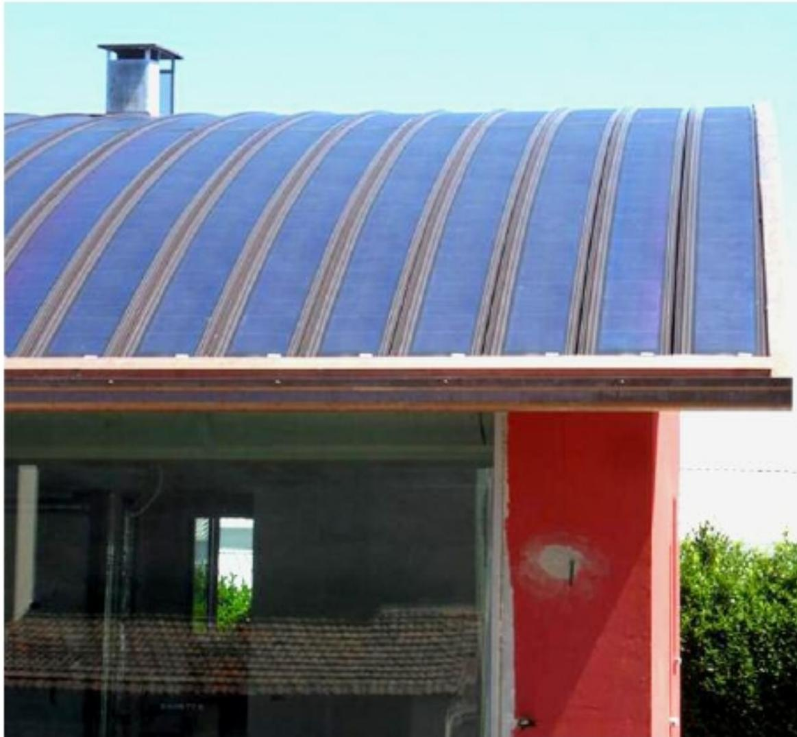
**Note.** Modulo fotovoltaico composto di nastro fotovoltaico su supporto rigido.
