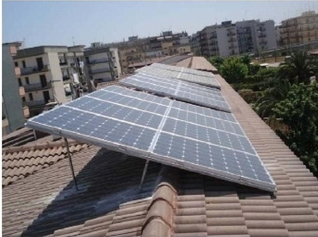
**Esempio di installazione non idonea alla classificazione dell'impianto fotovoltaico nella categoria "su edifici" – Motivazione: i moduli non rispettano la geometria della falda di copertura**
