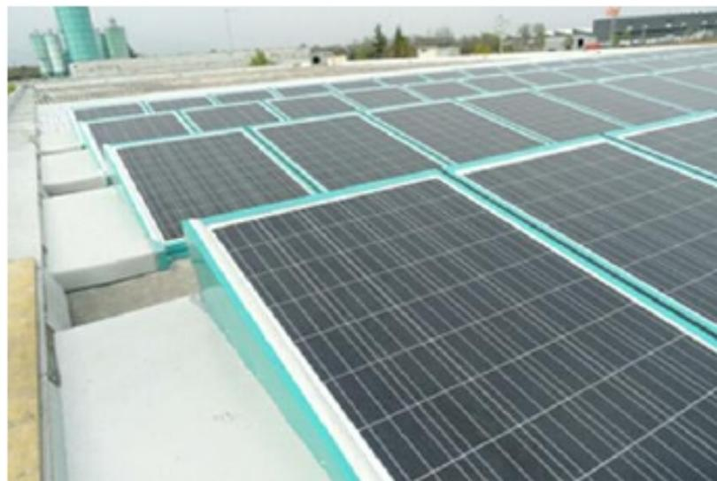
**Note.** La superficie dei moduli fotovoltaici garantisce, unitamente con il sistema di montaggio, la tenuta all'acqua e la conseguente impermeabilizzazione della struttura edilizia sottesa.
