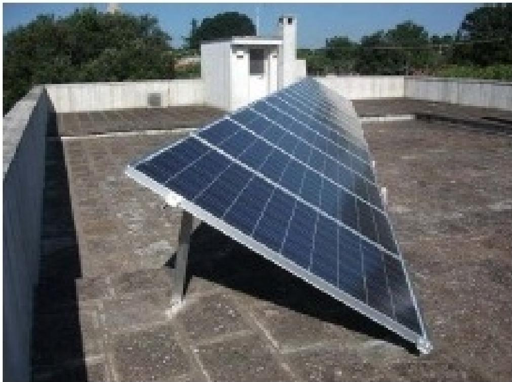
**Esempio di installazione idonea alla classificazione dell'impianto fotovoltaico nella categoria "su edifici" in caso di presenza di una balaustra perimetrale**
