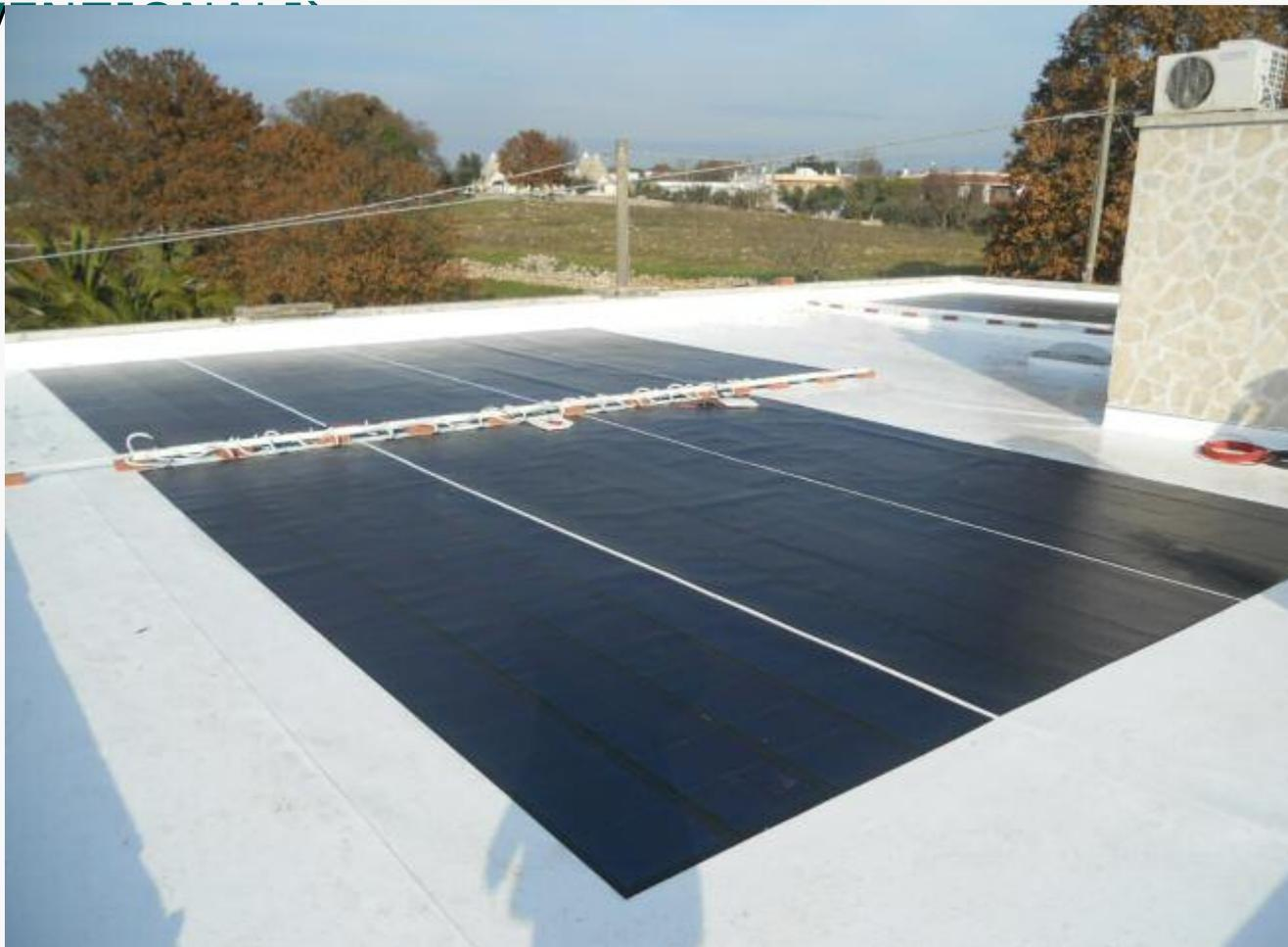
**Note.** Sostituzione di una guaina impermeabilizzante tramite un modulo fotovoltaico composto di nastro fotovoltaico su supporto flessibile impermeabilizzante. Il modulo fotovoltaico è certificato ai sensi della normativa tecnica riportata nell'Allegato 1 al Decreto. L'intervento di impermeabilizzazione è effettuato su tutta la superficie della copertura, anche soltanto con l'utilizzo del supporto flessibile.
